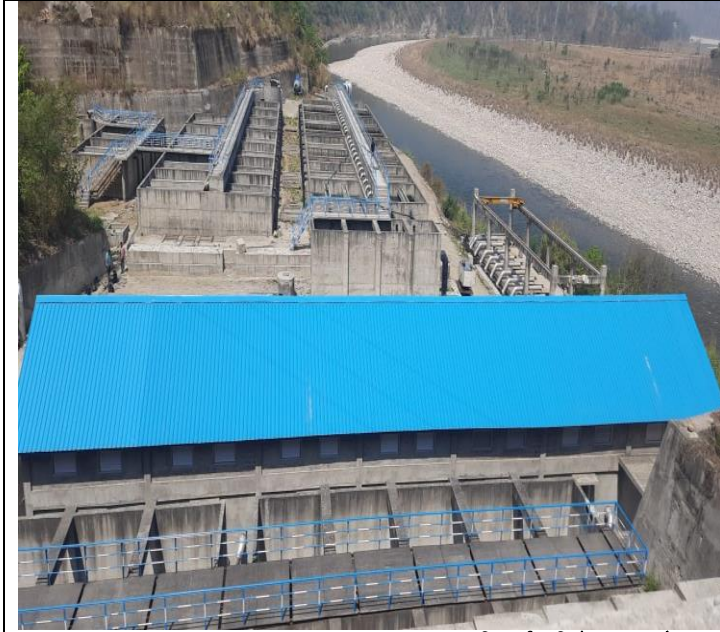
LEFT BANK PUMPHOUSE MIP NADAUN (मध्यम सिंचाई परियोजना नादौन)
